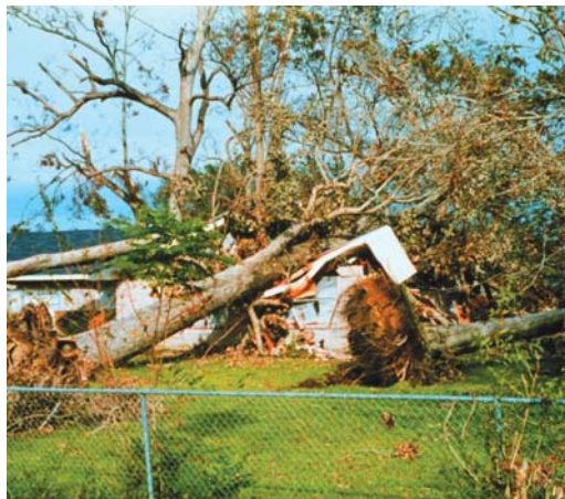
Destrozos producidos por el viento.
